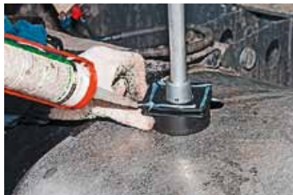
Посадку датчиков обеспечил специальный герметик
