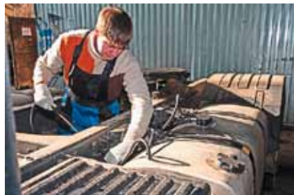
Дополнительная электропроводка прокладывалась в гофра
