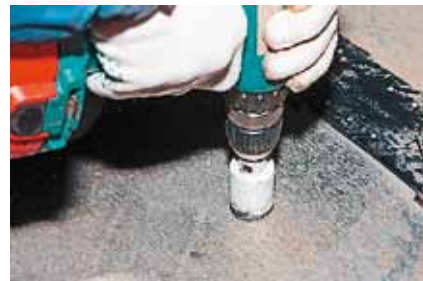
...а потом – до нужного диаметра специальной фрезой-коронкой
