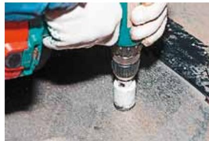
...а потом – до нужного диаметра специальной фрезой-коронкой
